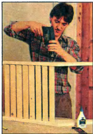
Дополнительные шурупы надежно фиксируют планки.
