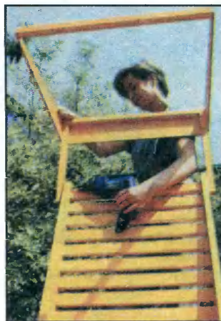
Каркас для тента крепят с помощью двух шурупов.
