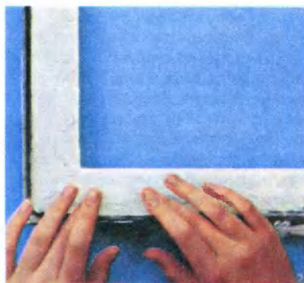
4 Наложите на влажную шпаклевку форму и слегка вдавите ее в шпаклевку.
